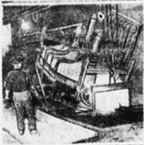
В этой печи ненужные стружки снова превращаются в металл.
